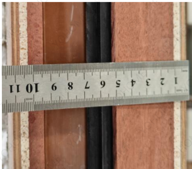
Photo 6 –Door Frame Jamb
