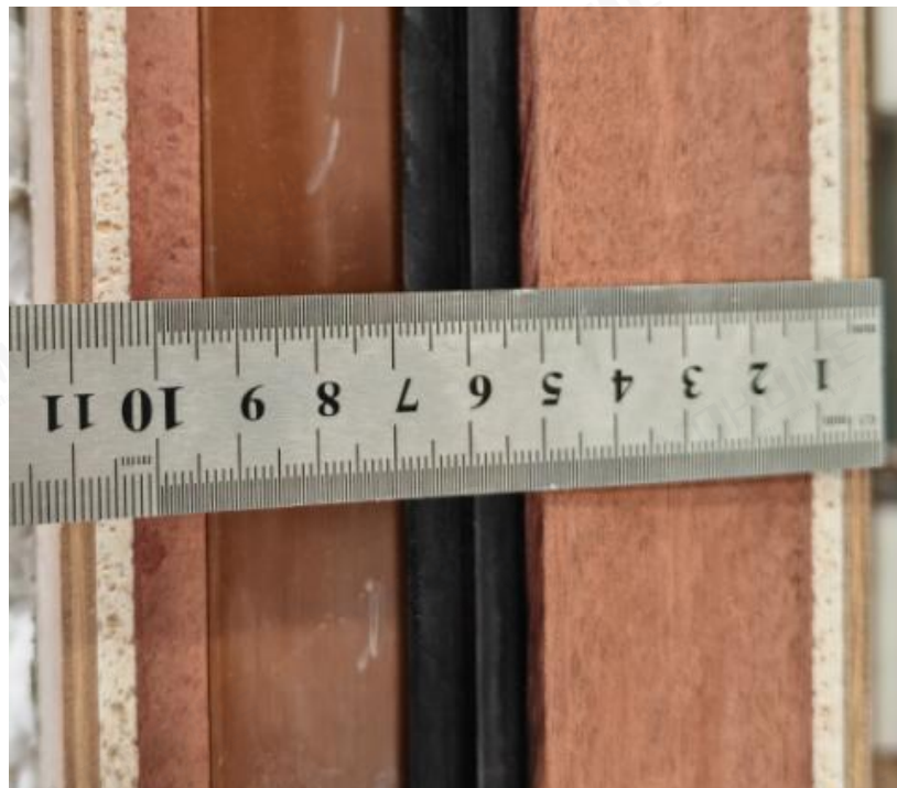
Photo 6 –Door Frame Jamb
